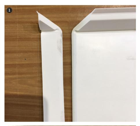
2 Danach wird die kurze Seite zur Wand gerade abgeschnitten und die Schnittkanten mit Sekundenkleber fixiert.
